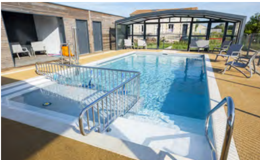
Created by Harmonie Piscines in Puilboreau for Nature et Résidence Arzal .
